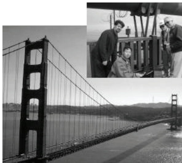
Figura 7. Monitoreo de Estructuras
